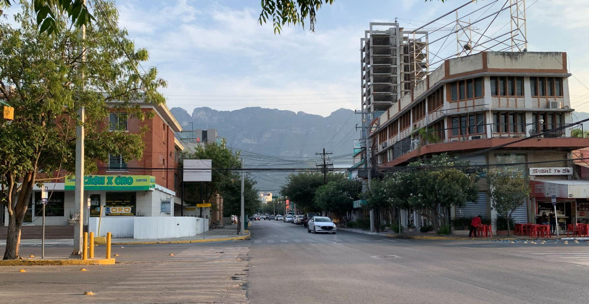
Antes - Intersección Río Orinoco y Río Tamazunchale
